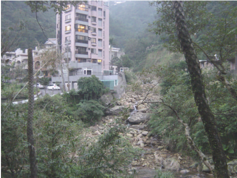
基隆河一支流康誥坑溪沿岸之聚落，房屋建築在坡地之上，河流又不斷侵蝕，但在汐止山的山坡地上處處可見此種社區建築。
